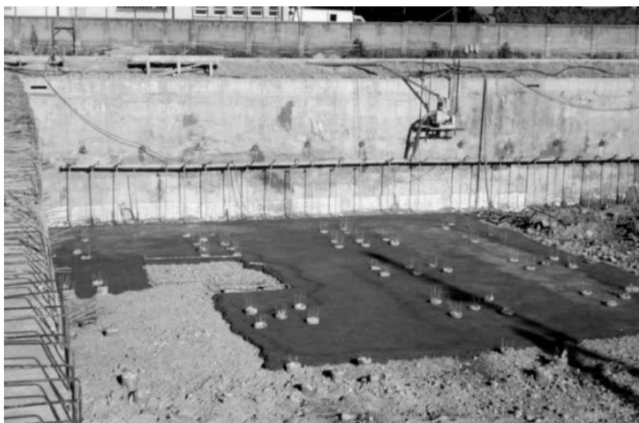
Naturalmente non sempre è logisticamente possibile eseguire il movimento terra necessario per l'applicazione di questa tecnica ed in questi casi esso viene sostituito con protezioni meccaniche (palancolati) o strutturali (paratie e diaframmi).
